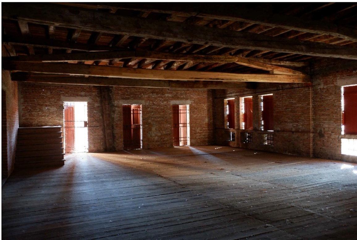
Vista interna angolo sud-est piano primo
