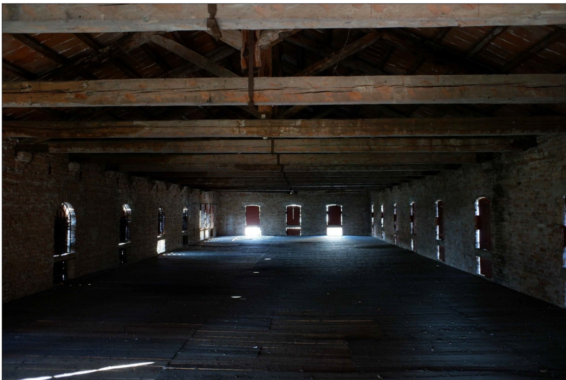
Vista interna angolo nord-ovest piano secondo
